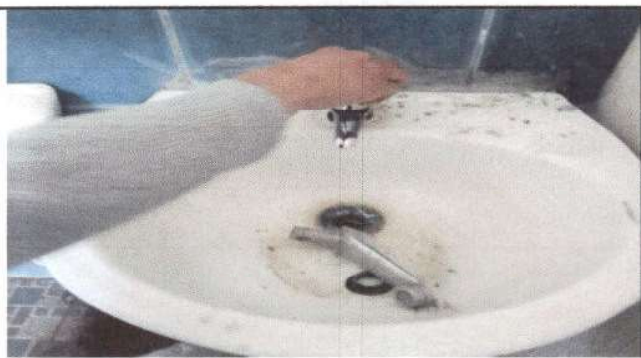
Foto 15: Instalación de llaves de lavamanos en modulo de baños
