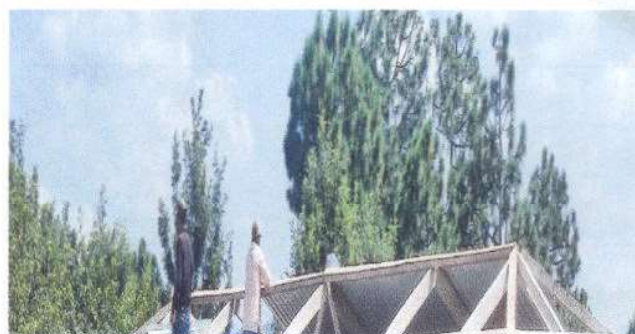
Foto 2: Sustrucion de capote de lamina para lamina troquelada en modulo de cocina
