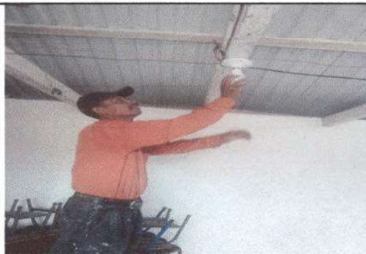
Foto 8: Sustitución de Platafoneras en modulo de cocina
