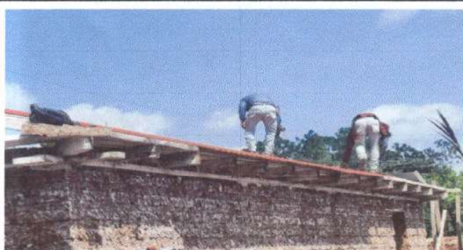
Foto 3: Sustrucion de los elementos de fijacion en modulo de cocina
