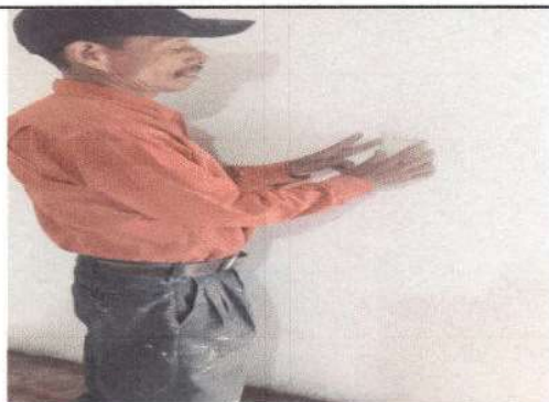
Foto 9: Sustitución de inerruptores simples en modulo de cocina
