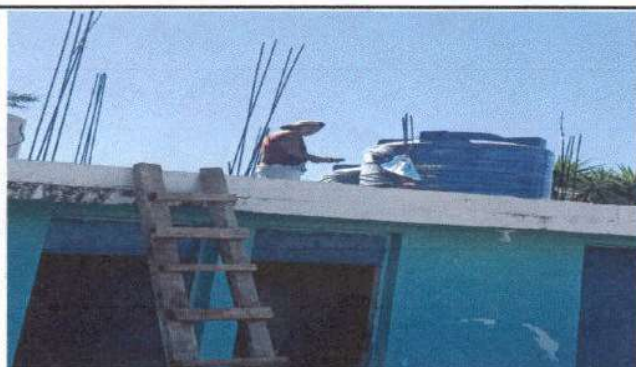
Foto 12: Sustitución de deposito de agua 1250 Lts. En modulo de baños
