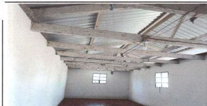
Foto 11: Sustitución de cableado eléctrico sólido en modulo de cocina
