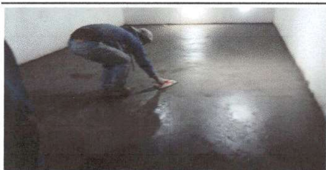
Foto 5: Sustrucion de piso de torta de concreto en modulo de cocina
