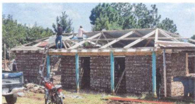
Foto 1: Sustrucion de lamina por lamina troquelada aluzinc calibre 26 en modulo de cocina
