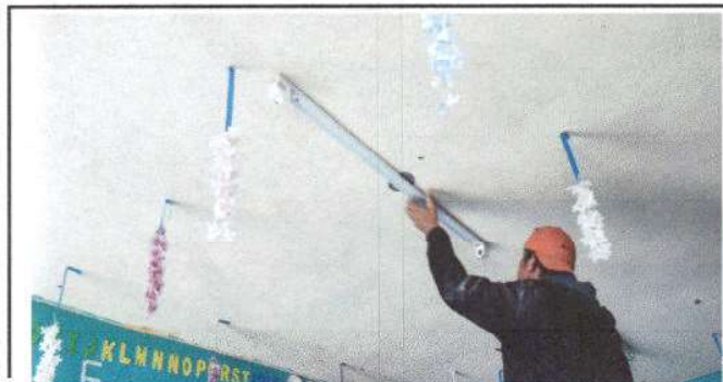
Foto 7: Sustitución de focos ahorradores en modulo de aula
