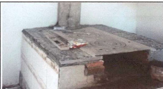
Foto 16: Sustitución de plancha de metal de 3 hornillas en modulo de cocina
