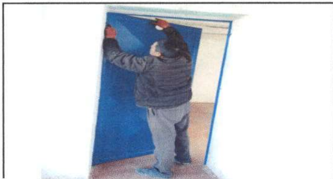
Foto 13: Sustitución de puertas de metal en modulo de cocina
