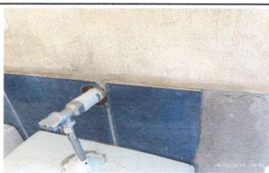
Foto 6: Sustrucion de llaves de migintorio en modulo de baño
