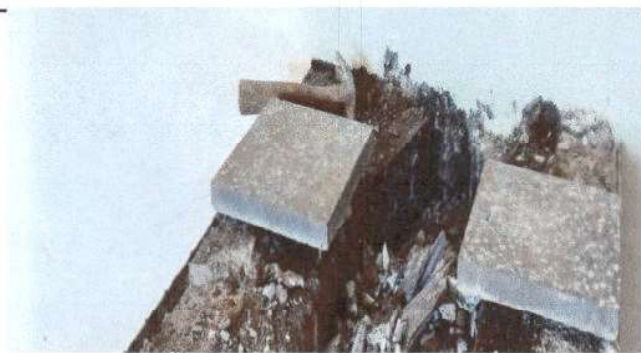
Foto 17: Sustitución de chimenea de concreto en modulo de cocina
