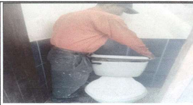
Foto 14: Instalación de inodoro en modulo de baño
